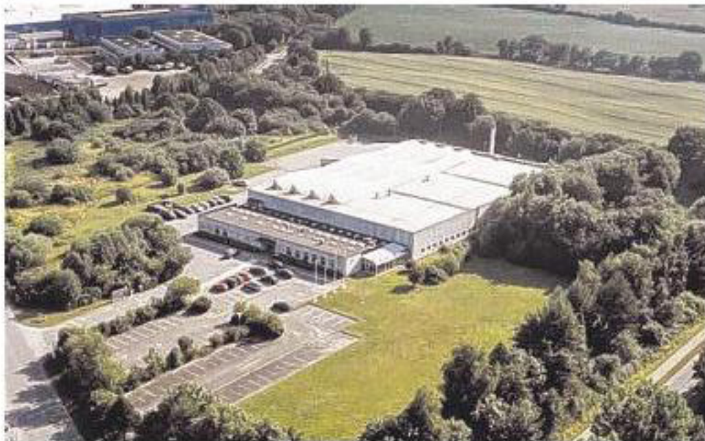
Die ehemalige Produktionsstätte von Danfoss Silicon Power im Gewerbegebiet St. Jürgen erstreckt sich über rund vier Hektar. PRIVAT
