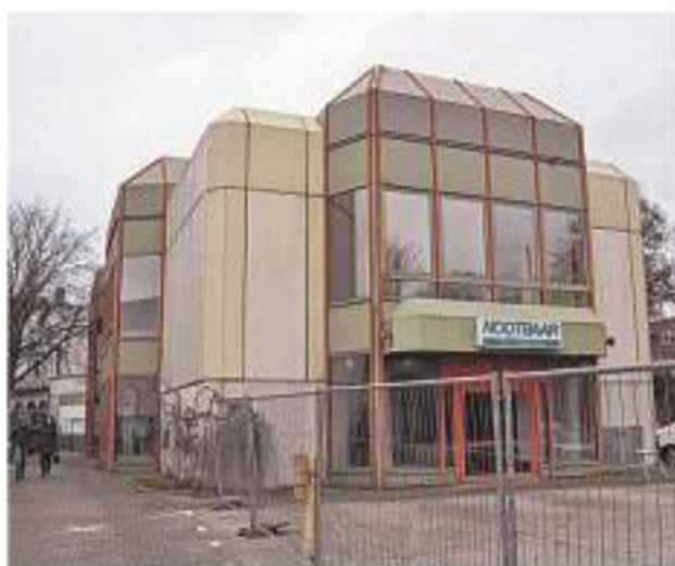
Der 1979/80 errichtete Anbau auf der Südseite wird komplett abgerissen.
